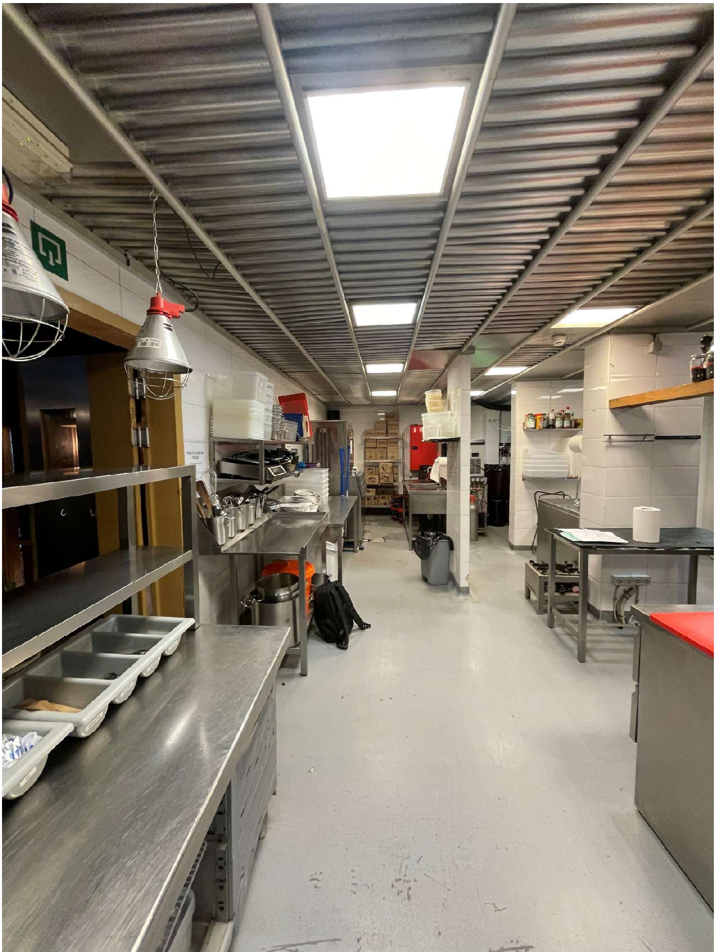
Cuisine très propre – faux plafond métallique sous poutres béton floquées RF
