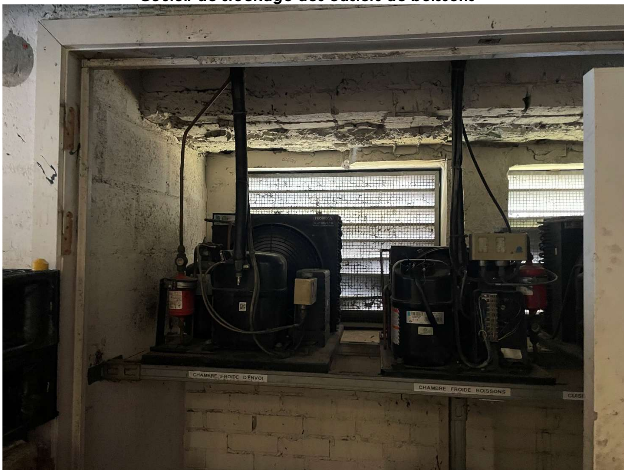
Ventilation et moteur condenseur des chambres froides vers l'extérieur
