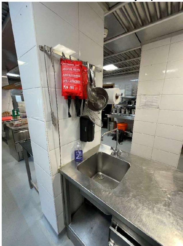
Couverture anti-feu à portée de main devant friteuse
