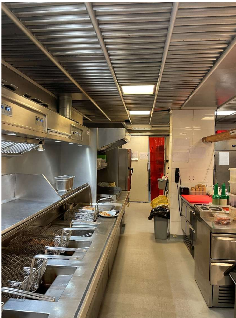
Friteuse PRO – 2 conduits de hotte jusqu'en toiture
